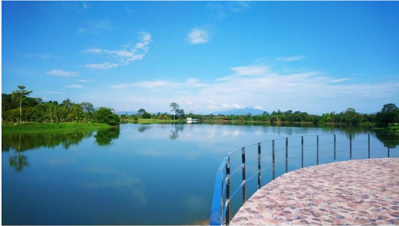
Reservoir 1 (Pruk Sa Chon Reservoir)
